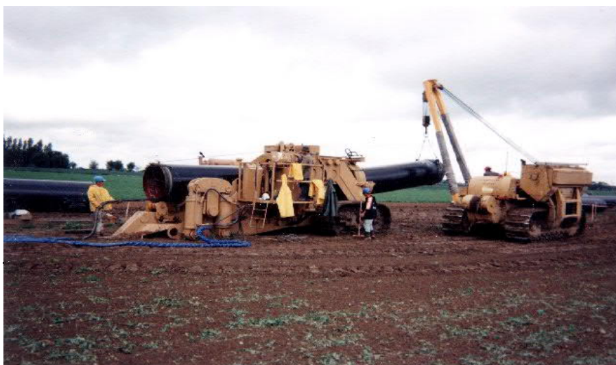
Figure n° 7 : Opération de cintrage des tubes (©MEDIATHEQUE GDF Suez)
